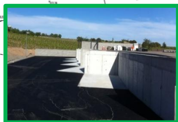
1100m 2 de voirie nouvelle
