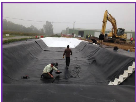
POSE GEOMEMBRANE ET GEOTEXTILE FILTRES
